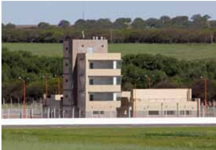
Edificio Torre de Control, Área Técnica, Sala VIP y podio. Todo en un paisaje natural bien pampeano rodeado de un gran caldenar, en un terreno con una posición espectacular, ya que desde cualquier punto se ve toda la carrera.
