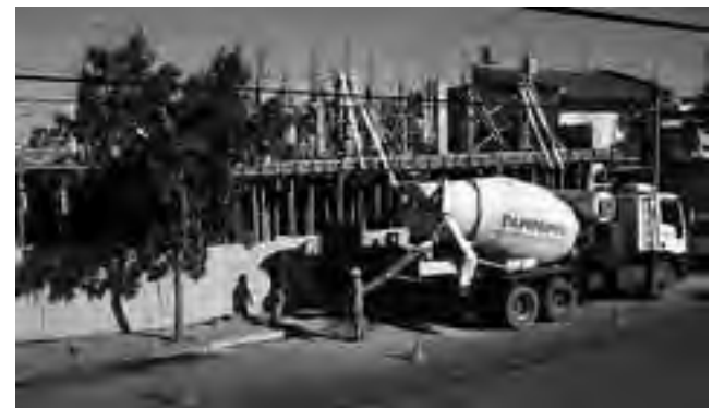
En la ex sede de CICAR, se construye un edificio de departamentos y oficinas
