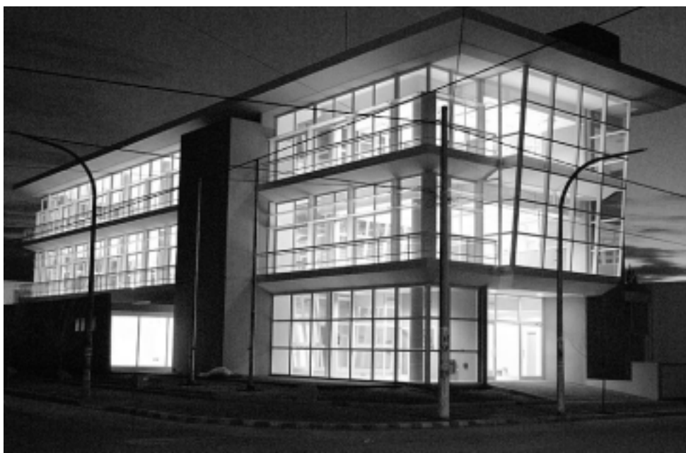
La nueva sede del Distrito 21° de la Dirección Nacional de Vialidad, ubicada en la esquina de Juan B. Justo y Villegas, en Santa Rosa, es inaugurada este viernes con la presencia de las máximas autoridades nacionales.
