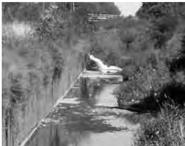
Canal a cielo abierto que acompaña la Ruta Nacional Nº 35 lado Este, en la zona de Villa Portal del Sur y Barrio Escondido. Es necesario entubarlo y hacer una calle colectora, para mejorar la salud de la población y la seguridad vial de este sector de la ciudad en el que se observa un importante crecimiento.
