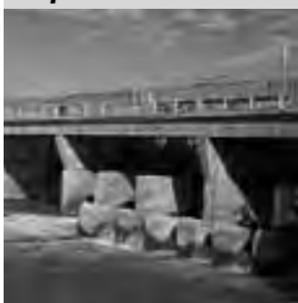
El puente dique "Punto Unido", fue inaugurado el 25 de mayo de 1972, construido sobre el Río Colorado, con un largo de 184m. Está constituido por un dique nivelador y obra de toma con capacidad para derivar hasta 120m3/s. Sirve además, como infraestructura del puente del cruce de la Ruta Nac. N° 151. Su construcción cambió la historia del cruce del Colorado ...
