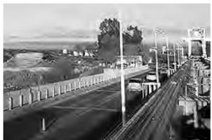
Culminaron los trabajos de reparación del puente Dique, que forma parte de la RN151. La obra consistió en la recuperación de la calzada y las defensas del puente que une La Pampa y Río negro, a través del Río Colorado...
