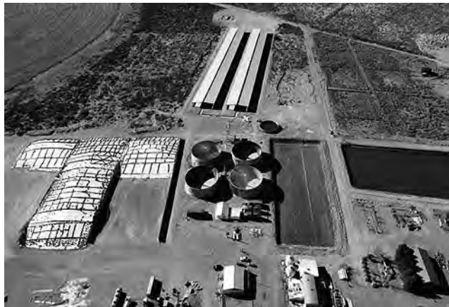
Cuatro digestores son los que producirán biogás mediante la utilización de estiércol -bosta bovina- o elementos de forraje fermentados como pueden ser maíz, sorgo o similar.
