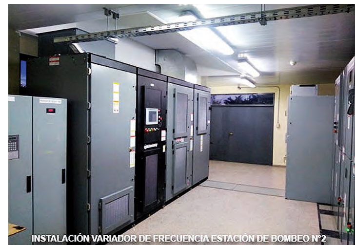
INSTALACIÓN VARIADOR DE FRECUENCIA ESTACIÓN DE BOMBEO N°2
